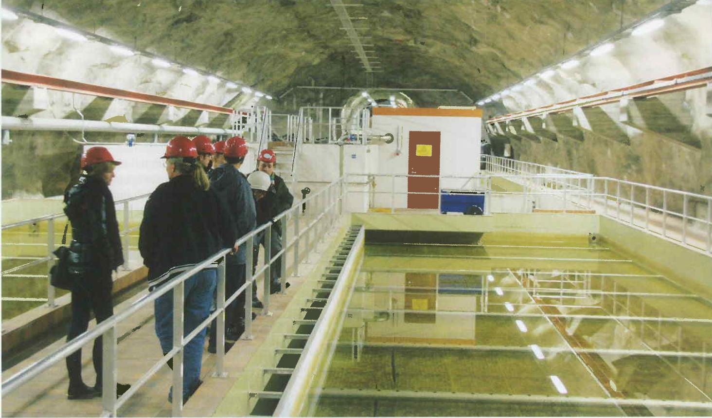
Befaring på vannverket. Foto: Kjetil Furuberg
